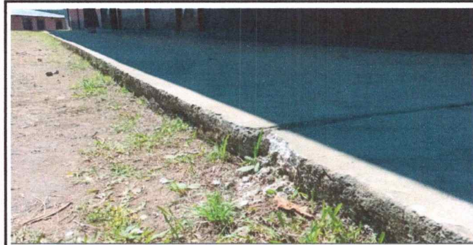
Foto 5. MODULO 2: Reparación y ampliación de piso en corredor.
